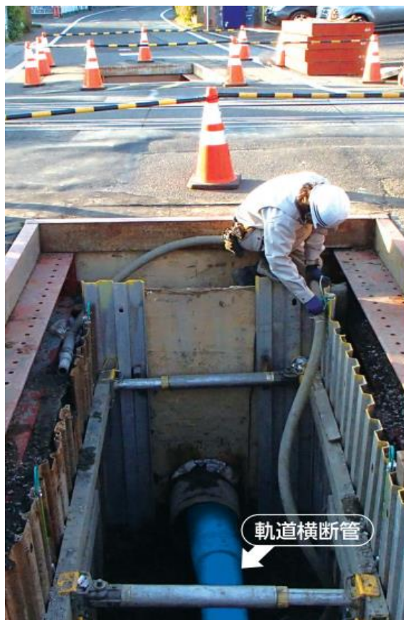
②鉄道軌道を横断する管路の耐震化工事(小田急線)
