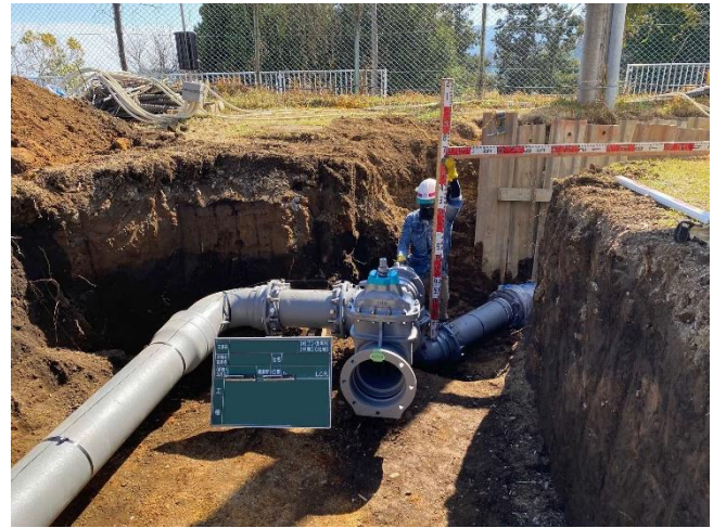
久野配水池の場内配管の耐震化
