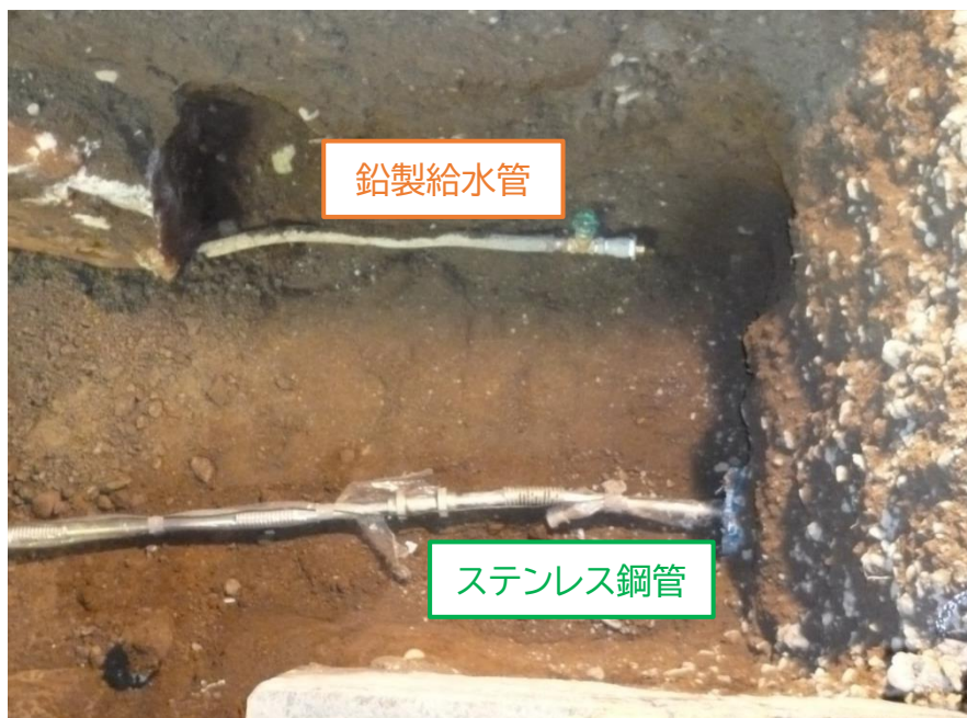
鉛製給水管から耐震管(ステンレス鋼管)への布設替え状況
