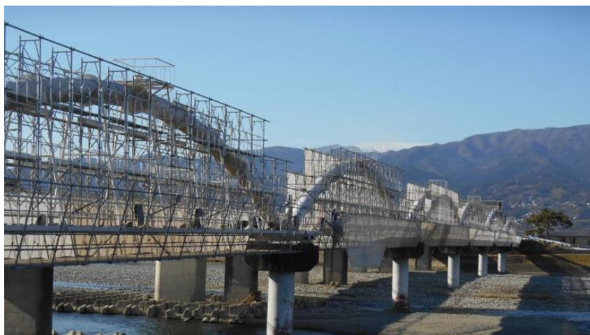
水管橋の維持修繕の様子
