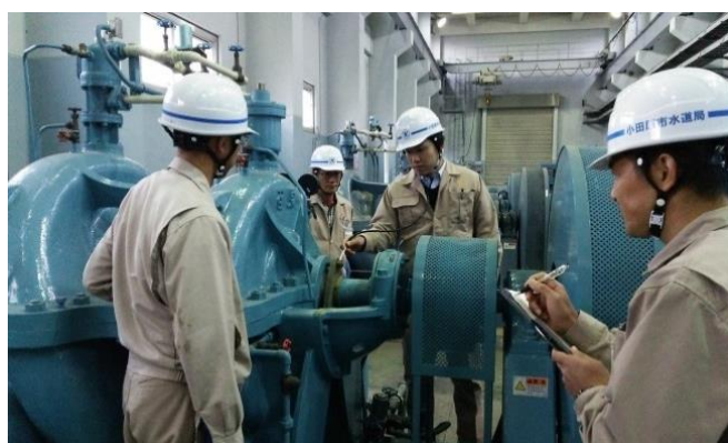
施設点検状況
