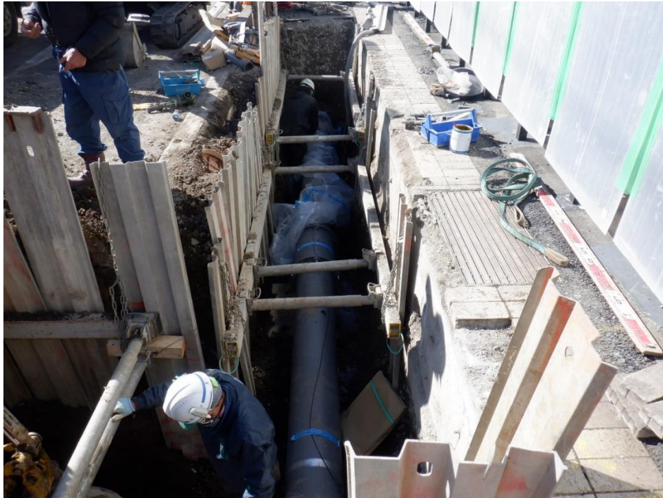
①重要給水施設(市立病院)に繋がる管路の耐震化工事
