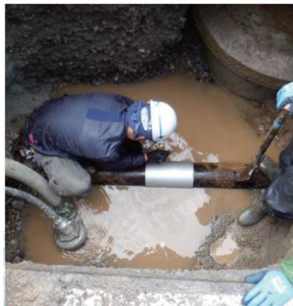
配水管漏水修理の様子
